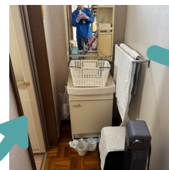
使わなくなっていた 洗面台を撤去して...
